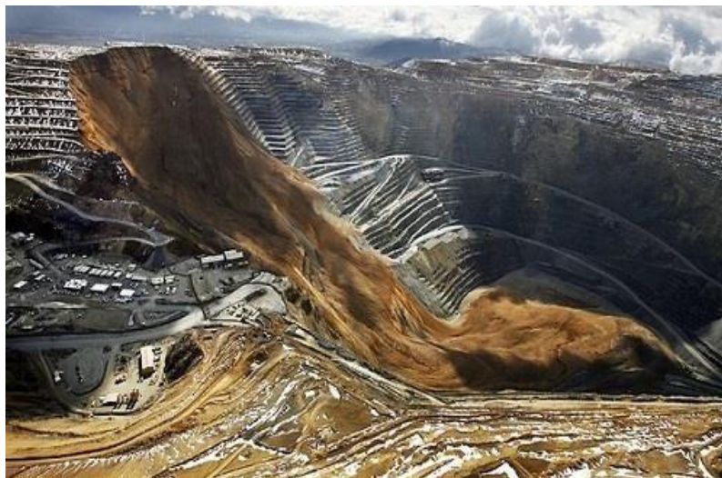
Εικόνα 23: Μαζική Κατολίσθηση στο Bingham Canyon Mine, Salt Lake City, Utah 2013 (Πηγή: https://skytruth.org )
