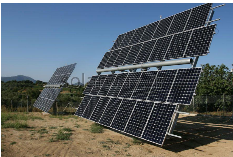
Εικόνα 29: Υπαίθρια φωτοβολταϊκή εγκατάσταση
