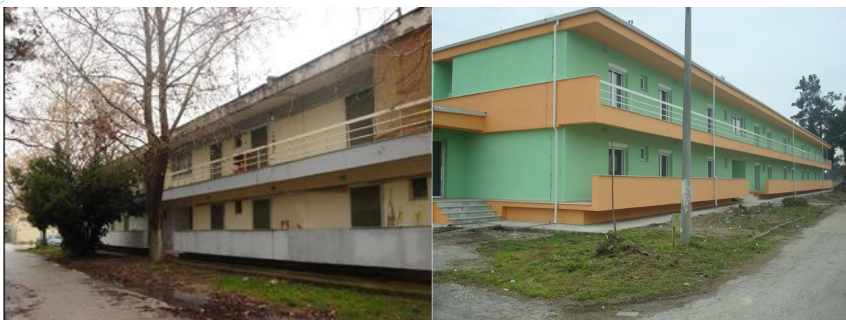
Εικόνα 21: Εφαρμογή θερμομόνωσης στην όψη του κτιρίου πριν και μετά
