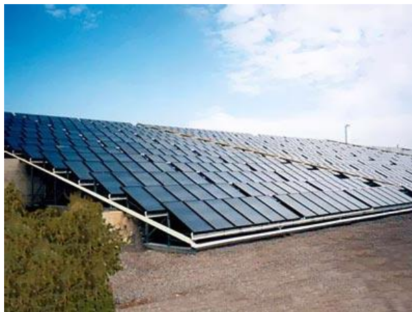
Εικόνα 51: Ηλιοθερμική συστοιχία
