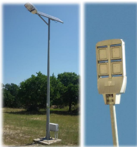
Εικόνα 66: Περιμετρικός φωτισμός μετά την επέμβαση
