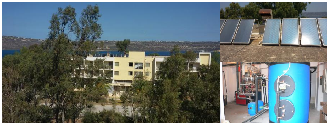
Εικόνα 53: Κτίριο ΛΥΣΚ, Ναύσταθος Σούδας, ηλιακοί συλλέκτες και δοχείο ZNX
