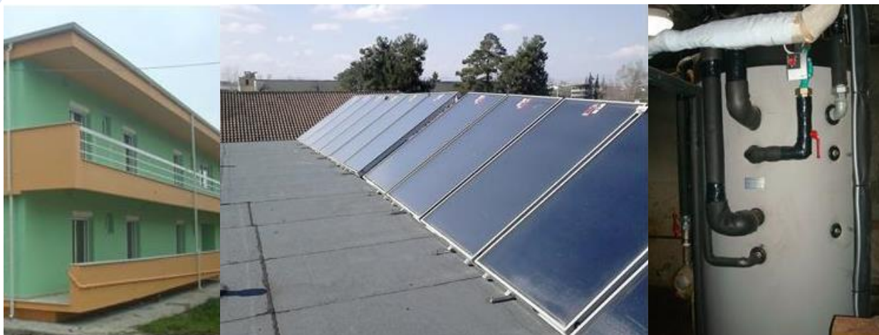
Εικόνα 52: Κτίριο ΕΡΜΗΣ, 110 Πτέρυγα Μάχης, Λάρισα - Ηλιακοί συλλέκτες, δοχείο ΖΝΧ
