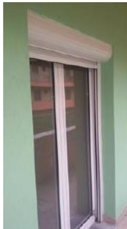
Εικόνα 28: Αντικατάσταση κουφωμάτων κτιρίου ΕΡΜΗΣ της 110 Πτέρυγας Μάχης, Λάρισα
